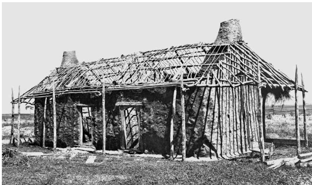
Каркас турлучного дома Адыги-бжедуги Кубанская область, г. Екатеринодар Экспедиция А. А. Миллера. 1910 г. РЭМ. Кол. № 2401-1
