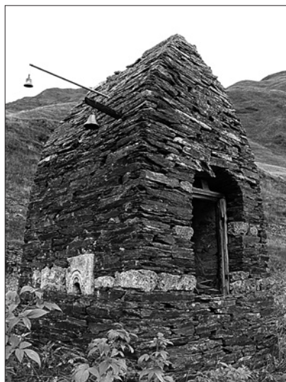
Рис. 7. Нижний Хохы дзуар с перенесенными травертиновыми блоками в кладке
