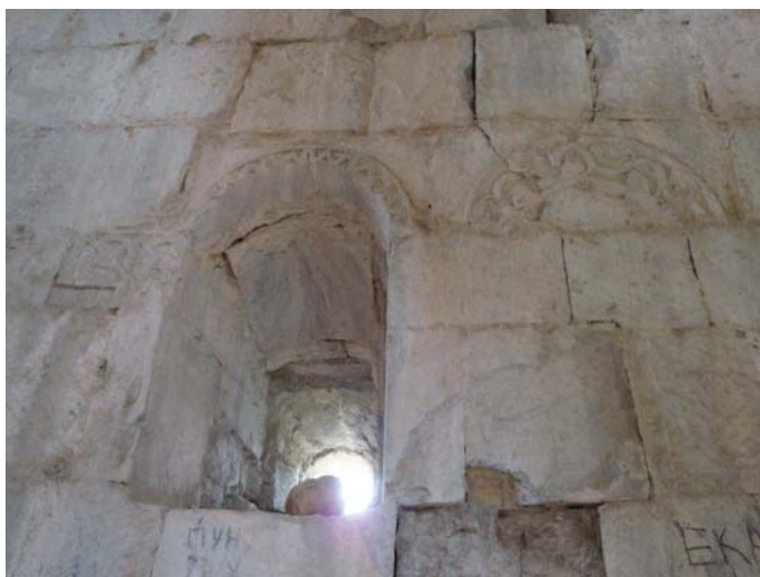
Рис. 4. Блоки, вторично использованные во внутренней облицовке северной стены собора в с. Агу-Бедия. Фото из архива Е. Ю. Ендольцевой.
