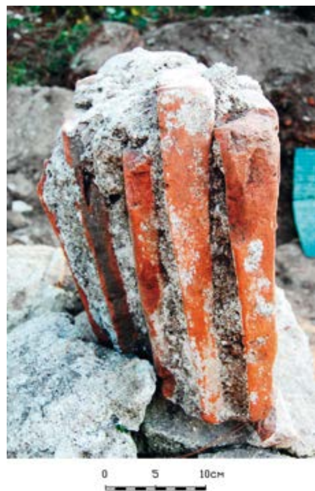
Рис. 62. Южная апсида, фрагмент арки, клиновидные кирпичи
