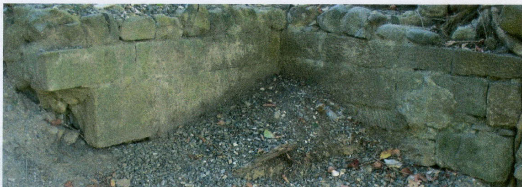
Рис. 1. Фрагмент сохранившегося участка стены квадратной каменной кладки.
