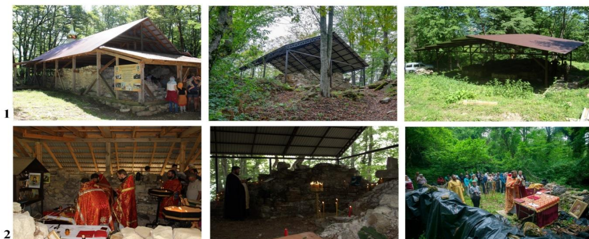
Рис.3. 1 – Временные защитные сооружения над остатками базилик; 2 – Поминальные литургии в честь святых покровителей.
