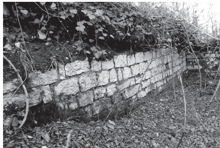
3. Квадровая кладка главной стены (протейхизмы)
