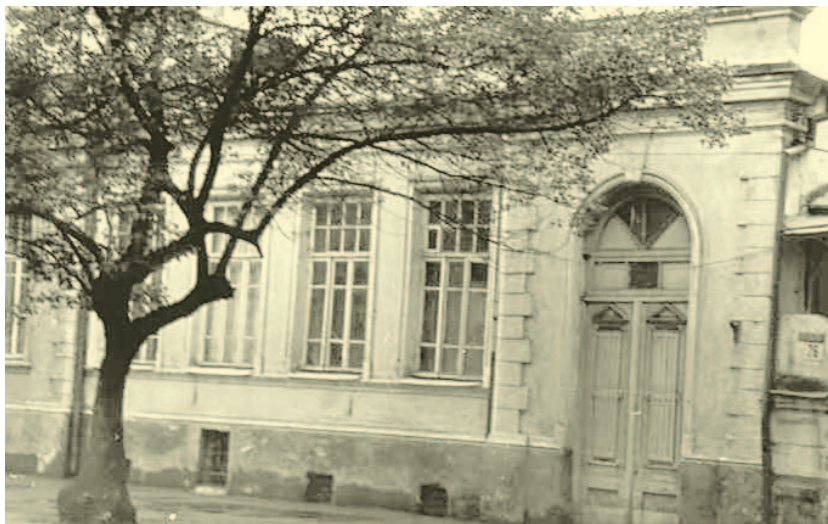
Το κτίριο του σχολείου το 1986, σε φωτογραφία του συγγραφέα
