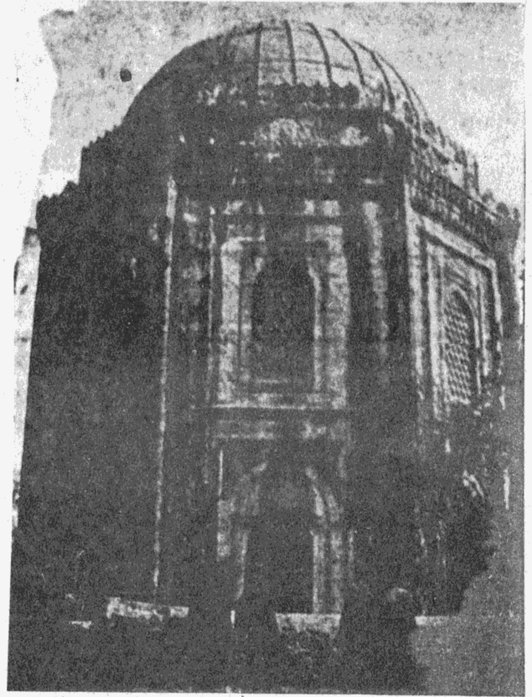
Bulunduğu sokağa da adını veren Hüseyin Paşa Türbesi Ho- caıveys'deki en zarif tarihi yapılardan birisi. Ne var ki oldukça bakımsız kalmış, Mahalleliler tarafından korunup kollanmazsa daha kötü durumlara düşeceği belli.
